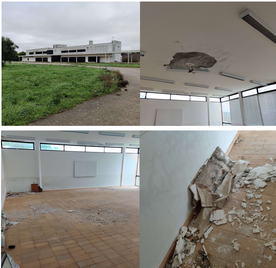
Figura 7 – Estado de degradação de algumas divisões do edifício principal da Quinta do Bonito
