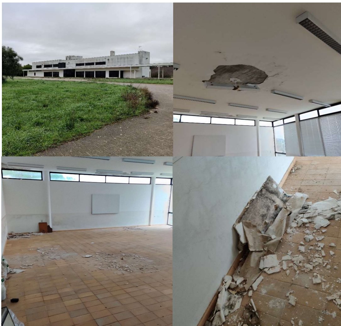
Figura 25– Estado de degradação de algumas divisões do edifício principal da Quinta do Bonito
