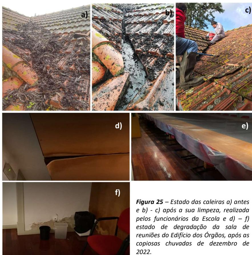
**Figura 25** – Estado das caleiras a) antes e b) - c) após a sua limpeza, realizada pelos funcionários da Escola e d) – f) estado de degradação da sala de reuniões do Edifício dos Órgãos, após as copiosas chuvadas de dezembro de 2022.
